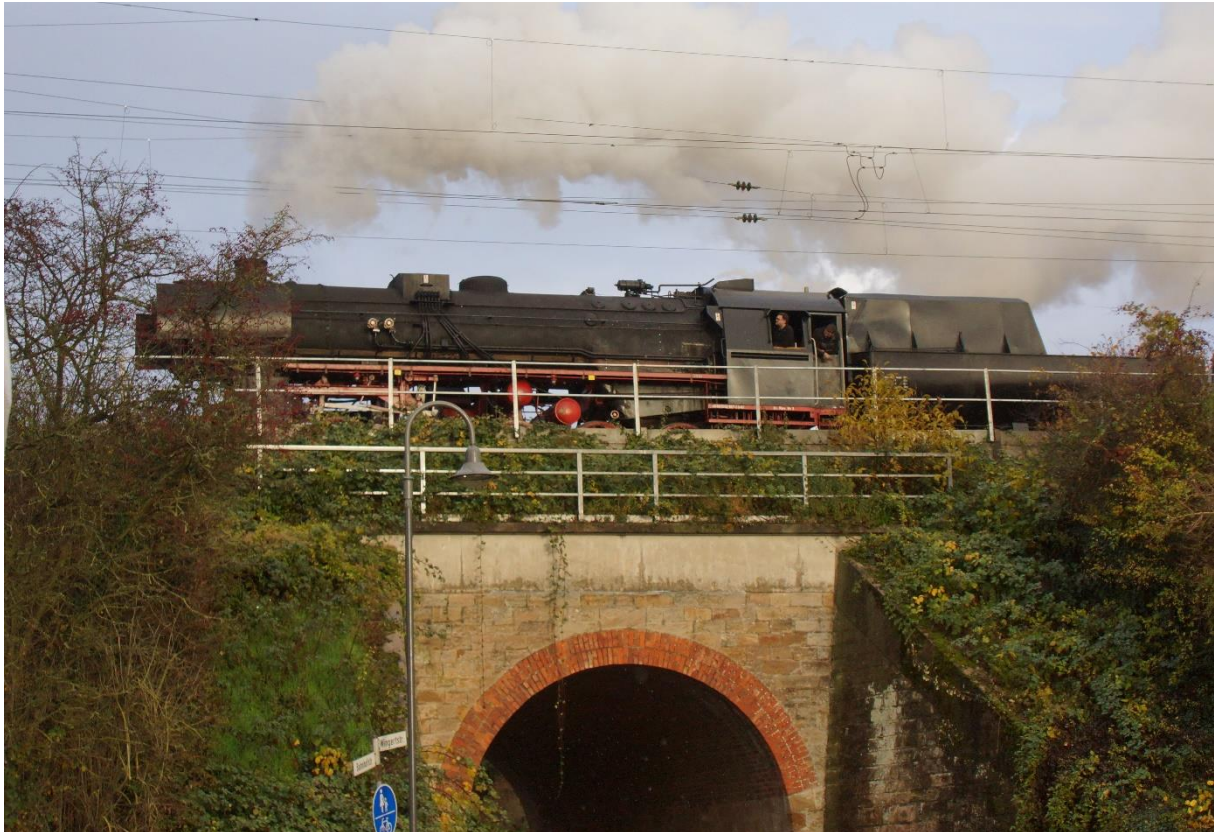
Lastprobefahrt der 52 4867 auf dem Viadukt in Heldenbergen am 18.11.2022
